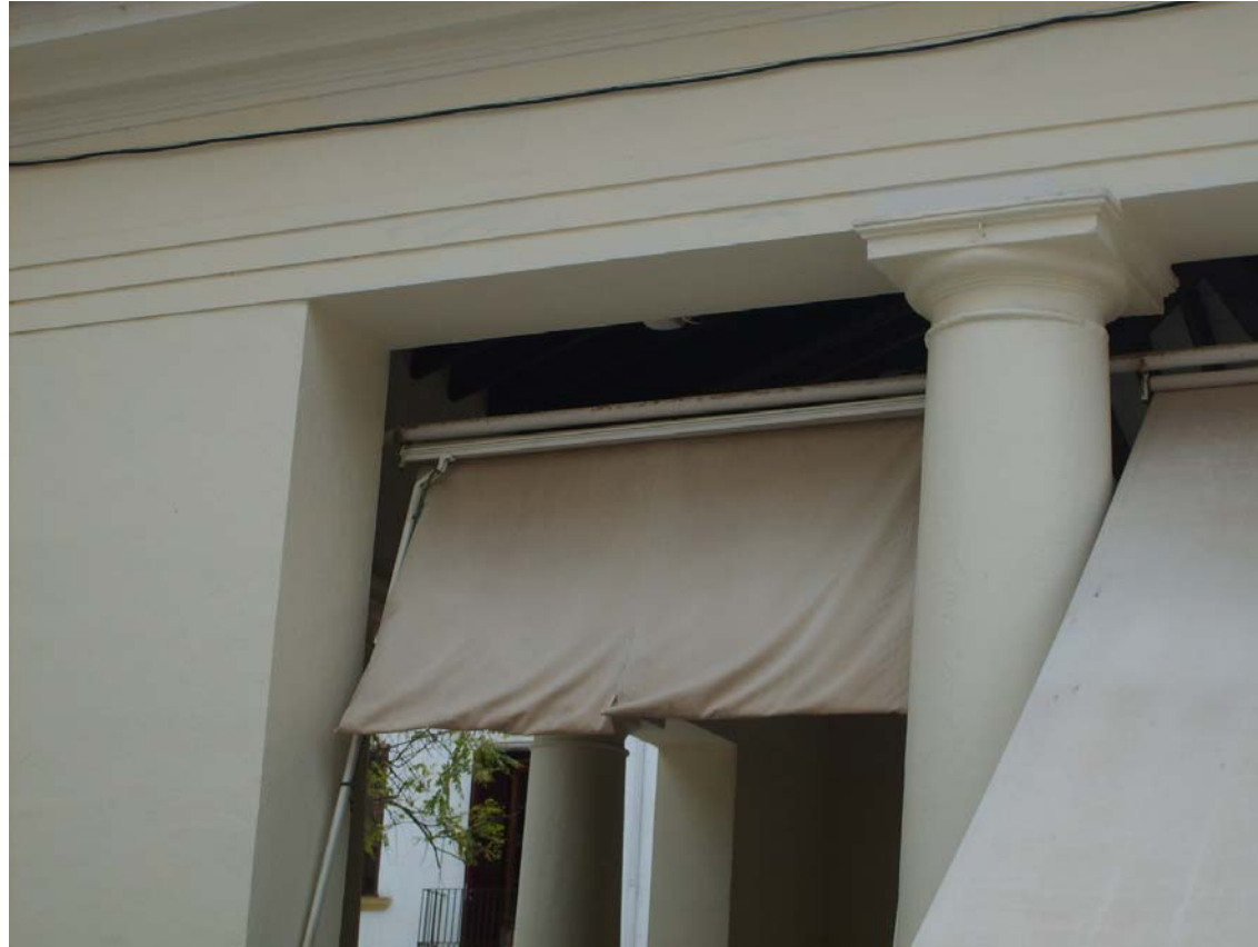
Es necesario dotar de un cerramiento adecuado al mercado.
