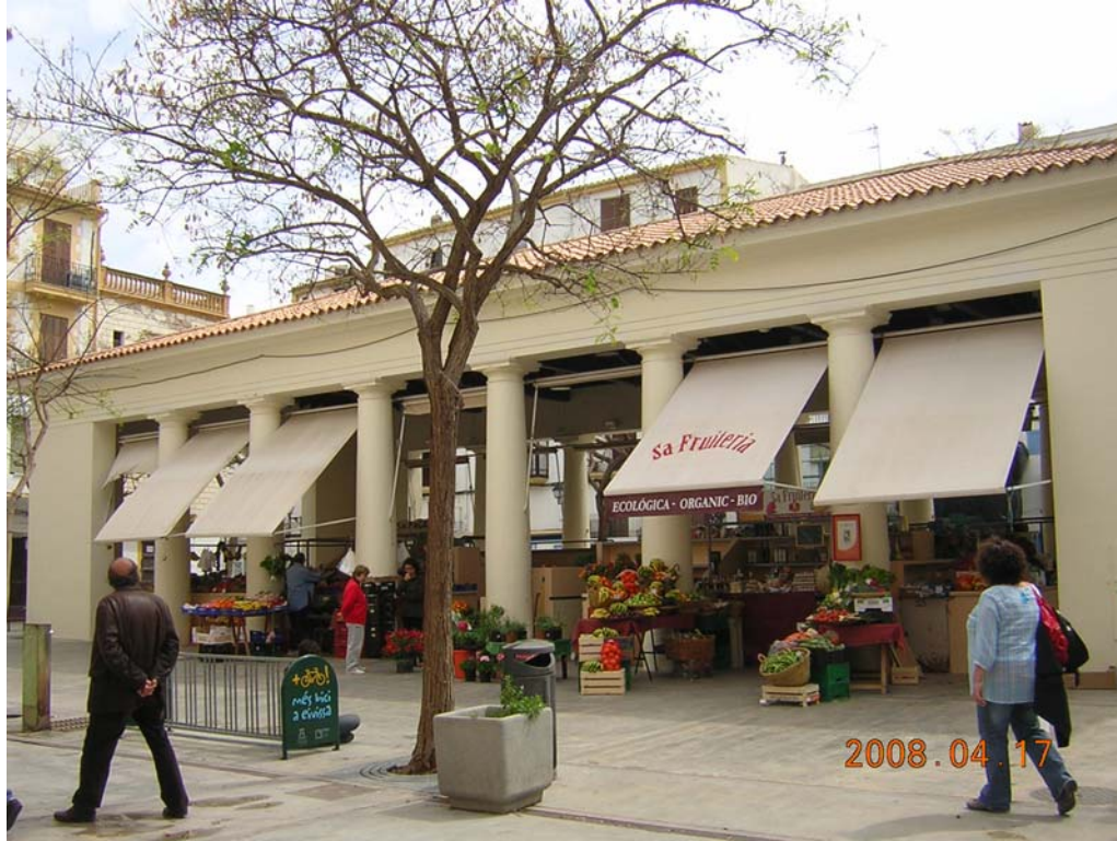
La fachada el mercado se integra de forma muy positiva con la plaza.
