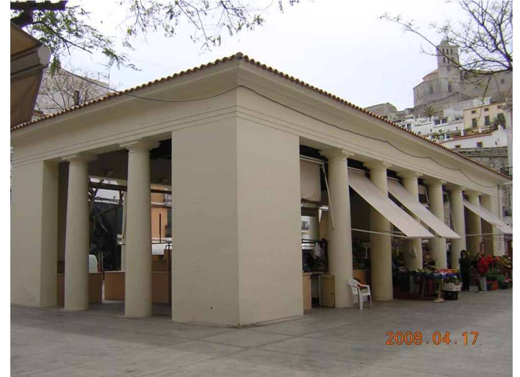
Es aconsejable limpiar de instalaciones y cableados la fachada del edificio para potenciar su presencia.
