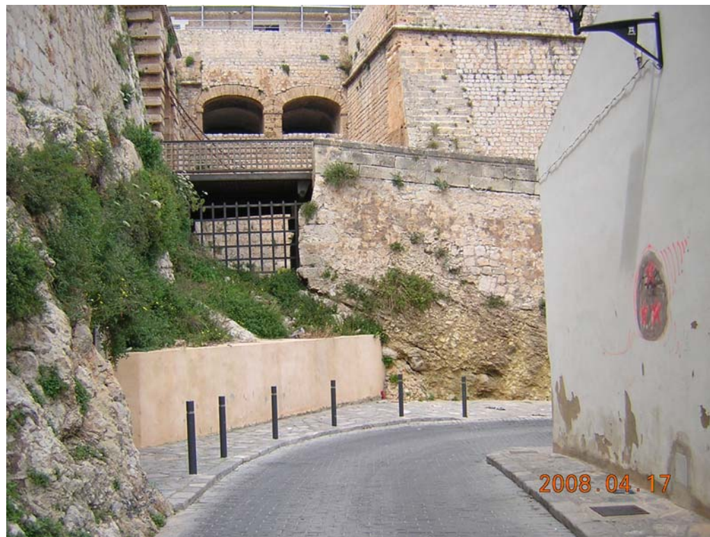
Se dan rincones de difícil control y con peligro de degradación.
