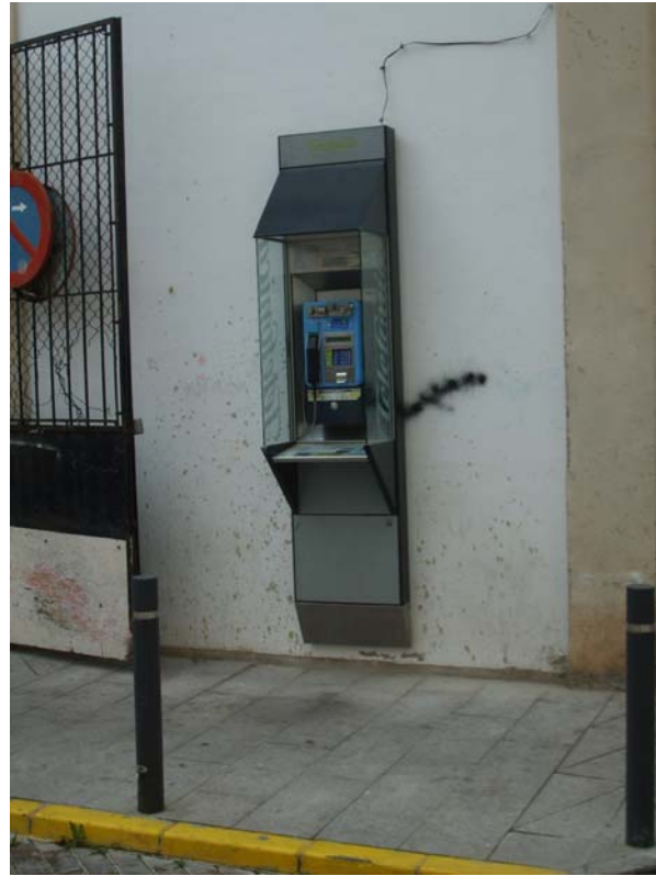
Cabina de teléfono adosada a fachada.
