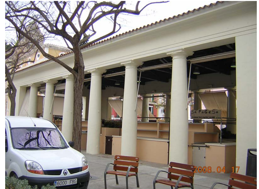
Esta fachada denota una ausencia de actividad muy negativa.
