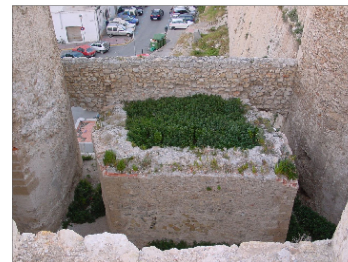
MURETE QUE CIERRA LOS MERLONES TIPO CALVI
