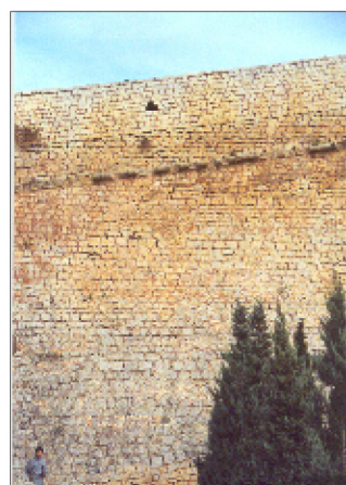
RELEVANTE DE PARAPETO
